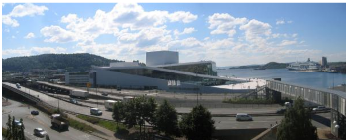
Oversiktsbilde av området.
