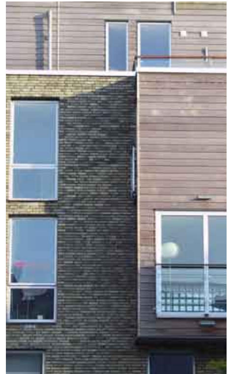
Gjenbrukte mursten på nybygget fasade.
