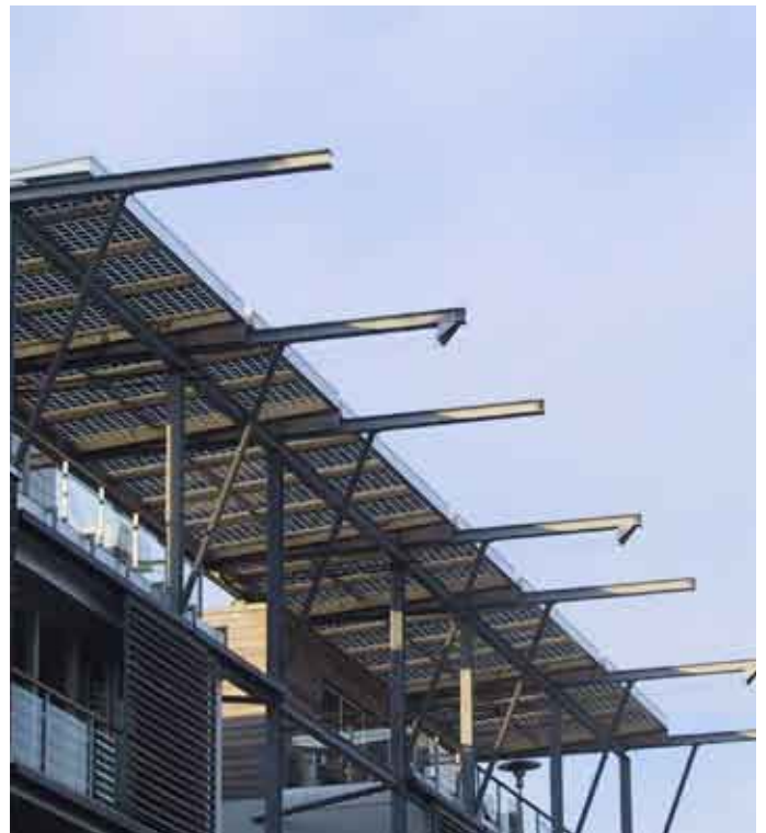
Solpanel på taket kan også skape behagelig skygge og le for boligene.
