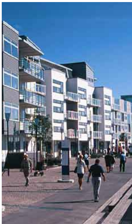
Byens fasader er byrommenes vegger. Her fasade mot havnepromenade i Malmö.
