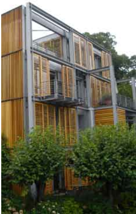
Solavskjerming av tre regulerer oppvarming og nedkjøling uten å bruke energi.
