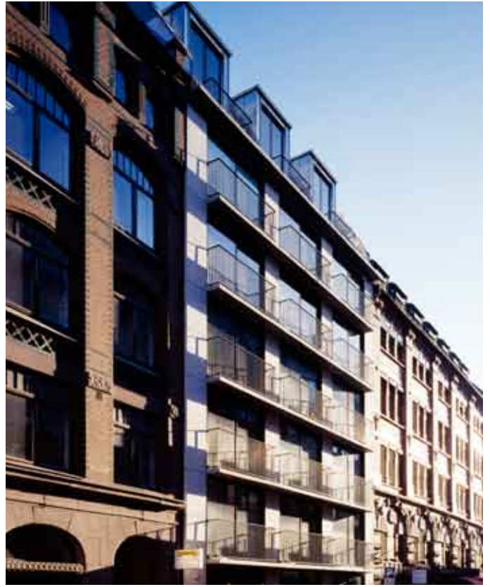
Skippergt 12, nytt boligbygg i Kvadraturen
