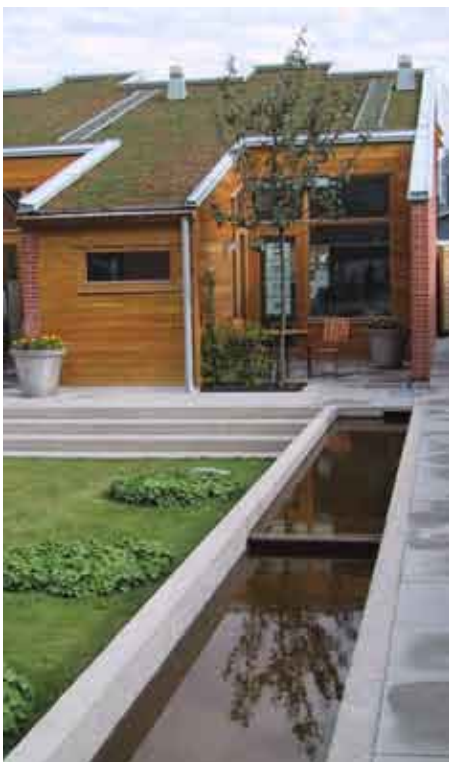
Grønne tak og åpne regnvannsoppsamlere øker naturlig regnvannsfiltrering.
